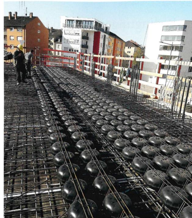
Der Einsatz der Cobiax-Technologie ermöglicht deutliche Einsparungen bei Material und Gewicht, so dass geringere Deckenstärken und Spannweiten von bis zu 20 m realisiert werden können.
