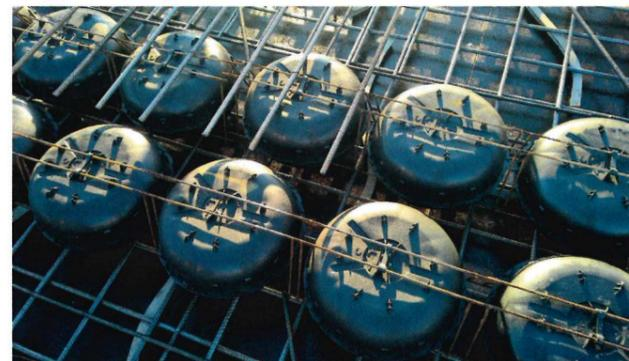
Das patentierte Cobiax-System besteht aus 250 cm langen Bewehrungsstahlelementen, in denen die Hohlkörper nach der Montage der Halbschalen fixiert werden.
